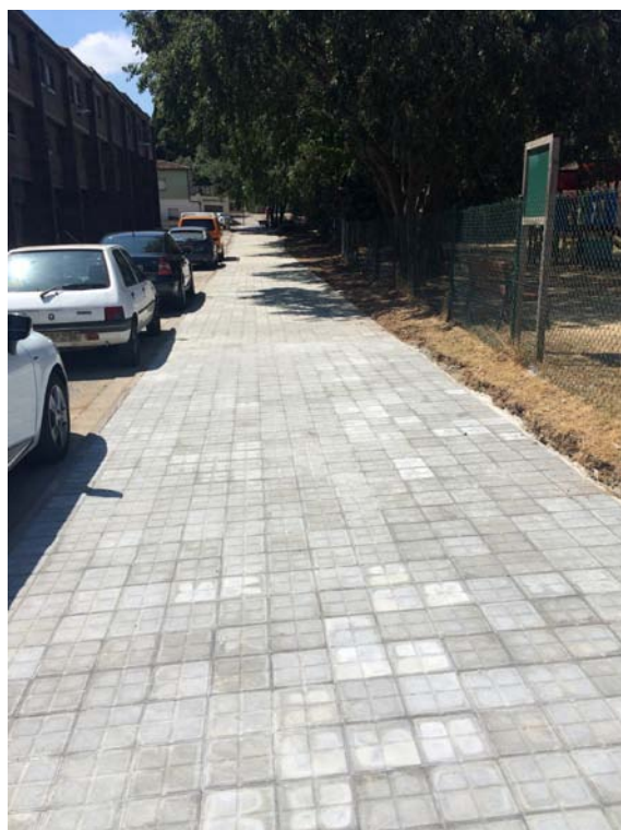
El carrer de Can Sisó amb la nova vorera ja acabada
