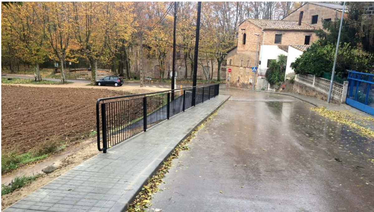
La nova vorera a l'entrada a la urbanització del Puig de la Fontpudosa
